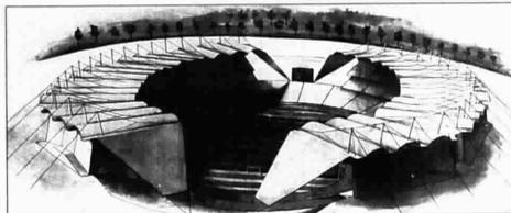
completando gli anelli che ospiteranno gli spalti, sono stati già eretti parecchi piloni che sosterranno la struttura di pannelli di alluminio termoisolato che coprirà i posti. L'erba sarà posta su un campo climatizzato. Risolte recentemente le modifiche relative alla sala stampa, alla tribuna dei VIP e al potenziamento dell'impianto di illuminazione per poter consentire le riprese tv ad alta definizione. L'aeroporto di Caselle si trova a 18 km dal centro della città.
